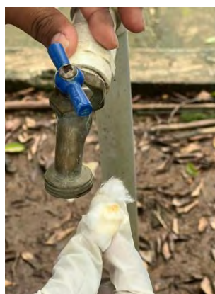
Figura 4. Toma principal del campus Minatitlán.
